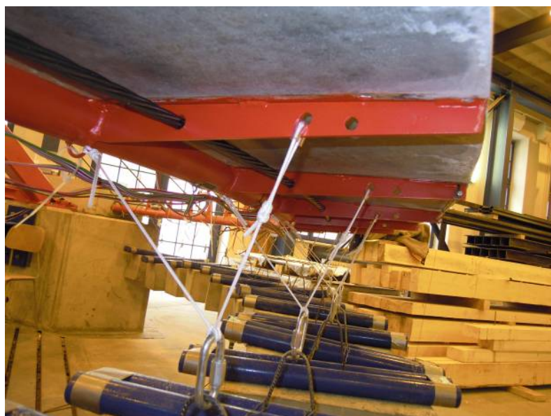
Obr. C.35 Mostovka zespod po odbednění
