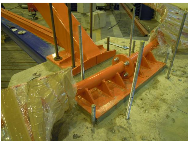
Obr. C.15 Podlití kotvení pylonu a spojení půloblouků mostovky
