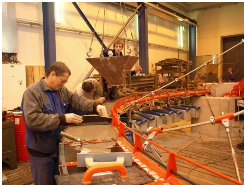
Obr. C.31 Betonáž visuté části
