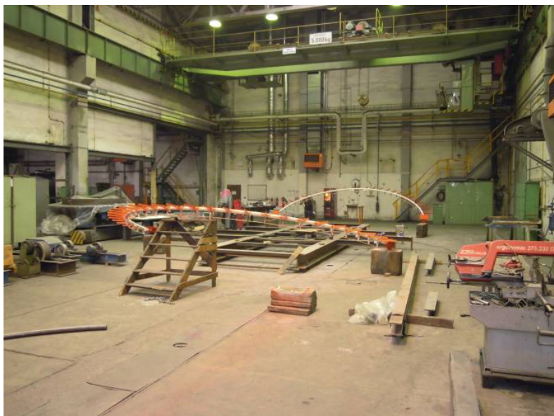
Obr. C.7 Nátěr ocelové části mostovky
