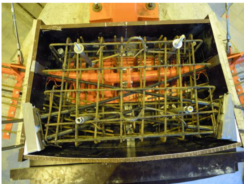
Obr. C.20 Bednění a výztuž kotevního bloku
